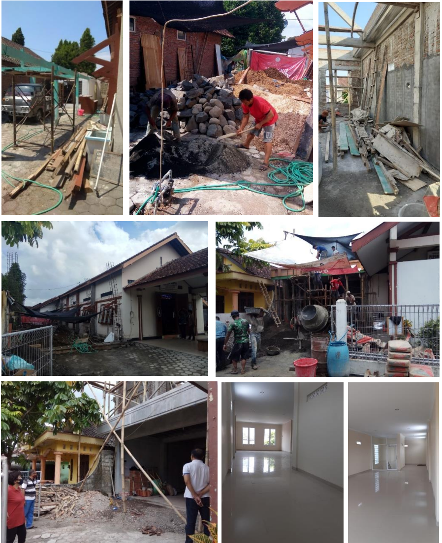
Gambar 4. Dokumentasi pembangunan Gedung Sekolah Minggu
