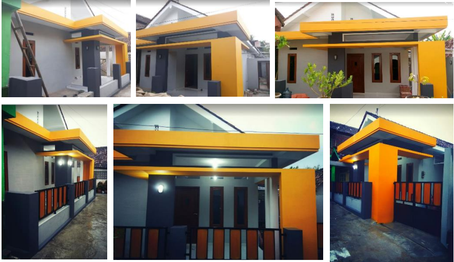
Gambar 3. Dokumentasi pembangunan Pastori GKJ Gamping
